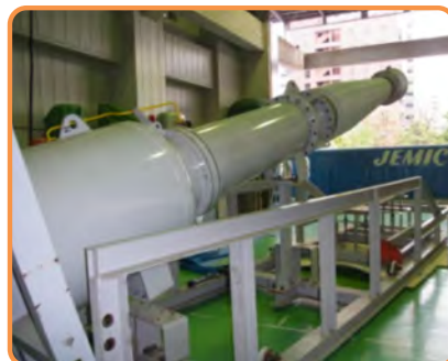
計器用変圧器
