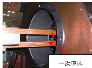
図 2 一次導体の設置例
