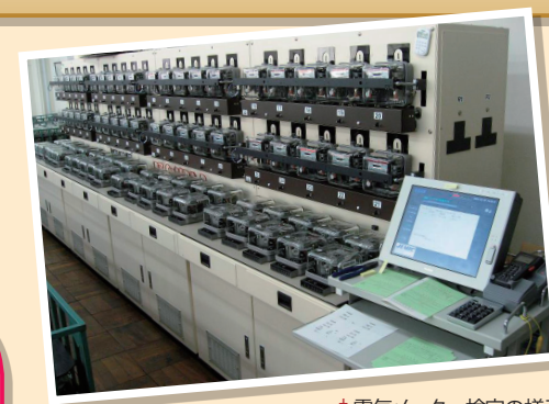
電気メーター検定の様子
