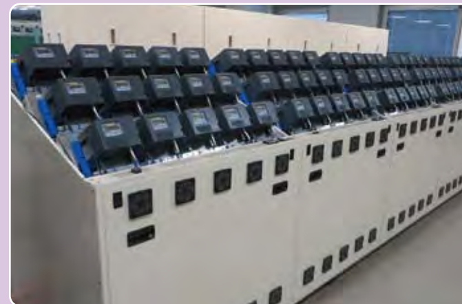
▲電気メーターの試験
